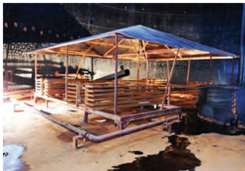
Рис. 2. Пример устройства характерного объема для подогрева вязких нефтепродуктов в емкости [5].
